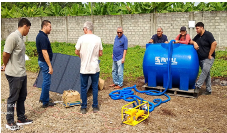
Eine Solarwasserpumpe wird gebaut
